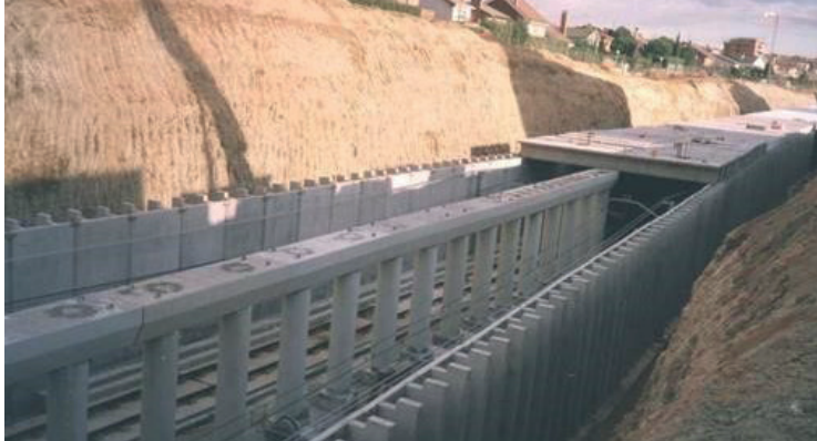
Cubricion Metro de Arganda, Spain
